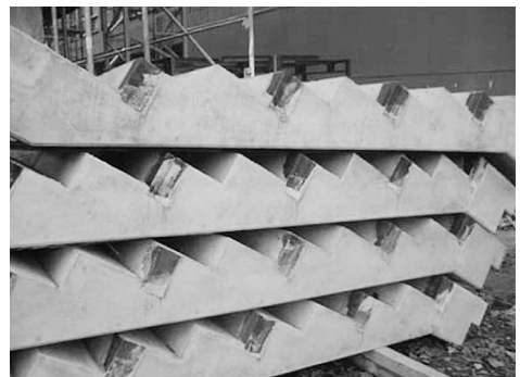
Abb. 17: Lagerung von Fertigteiltreppen
