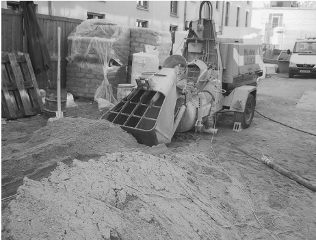
Abb. 9: Herstellung von Estrich auf der Baustelle
